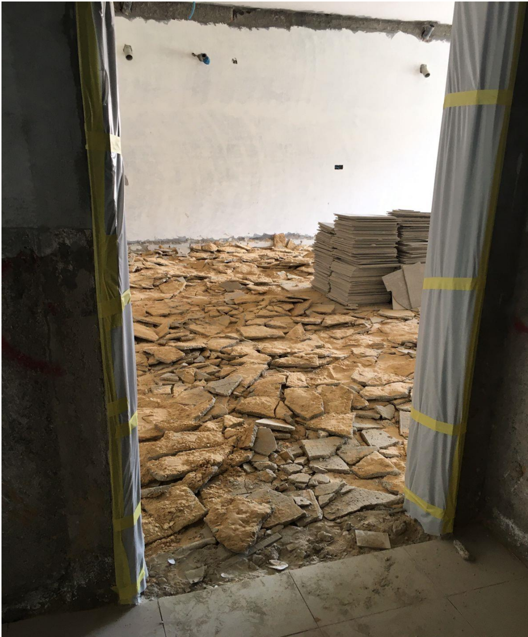
Wrapped steel door frame
