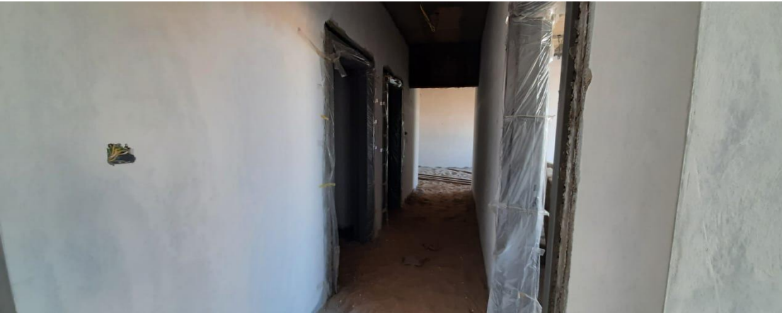
Wrapped steel door frame
