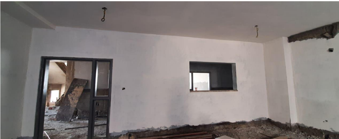
Unwrapped steel door frame
