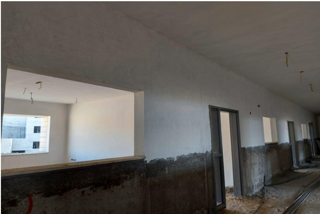
Unwrapped steel door frames
