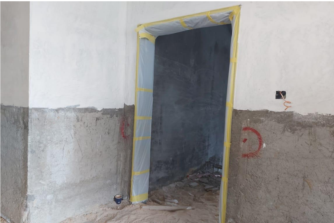
Wrapped steel door frame
