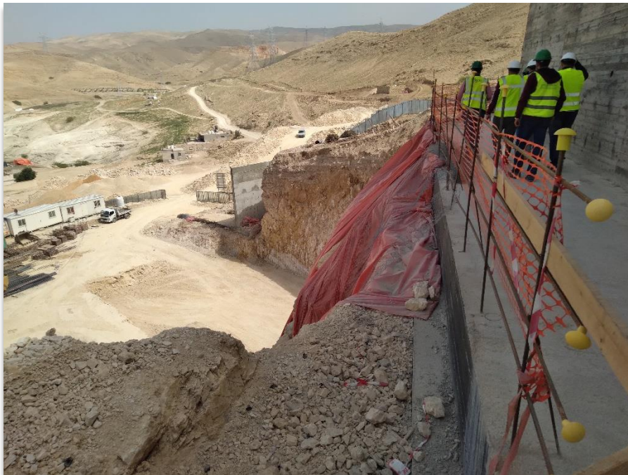
Figure 17: Edge Protection
